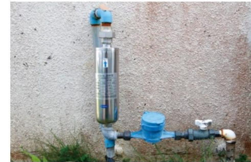
メーカーと協力して宮古島特有のカルシウム結晶化によるエコキュートのパイプ目詰まりを防ぐ軟水器
