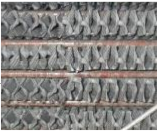
安裝 Emile，停止注入藥劑和排水 並連續運行 2 個月。銅管上的水 垢剝落了很多。
