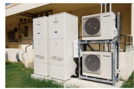
市営住宅に設置されたネットワーク型エコキュートは蒸給調整と温水提供を兼ねる
