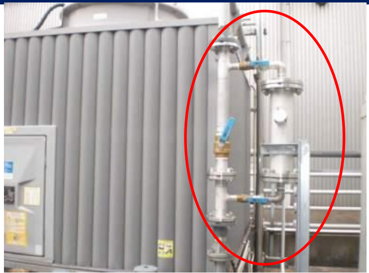
EMiIR在密閉型冷卻塔的安裝情況
